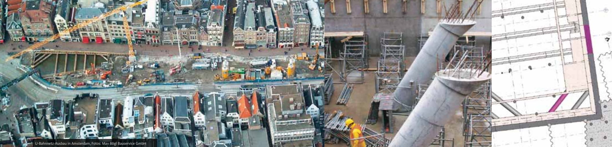
U-Bahnnetz-Ausbau in Amsterdam, Fotos: Max Bögl Bauservice GmbH
