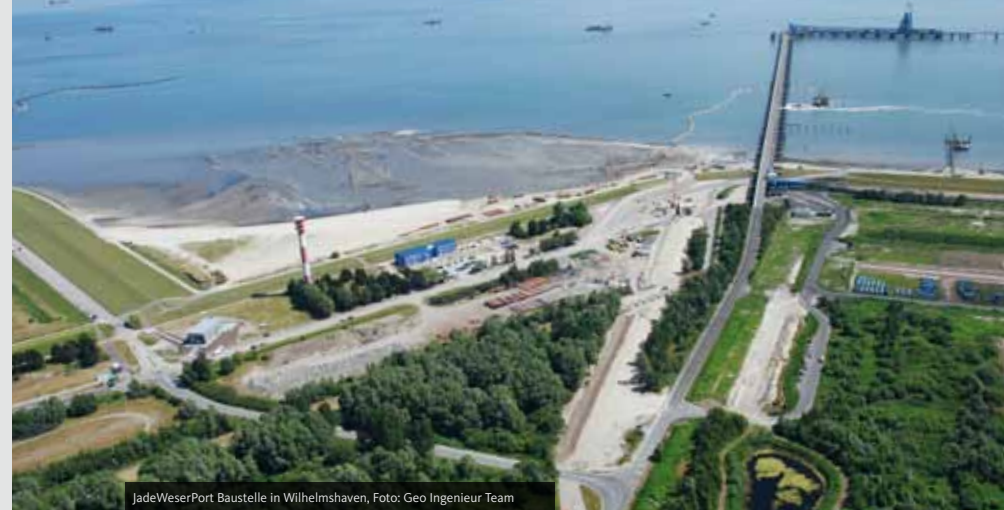
JadeWeserPort Baustelle in Wilhelmshaven, Foto: Geo Ingenieur Team
